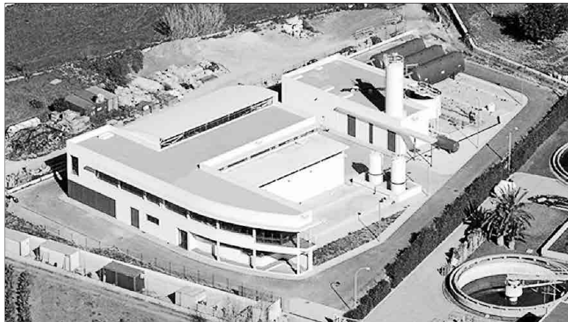
Imagen aérea de la desaladora de Santa Eulària. Foto: CAIB
