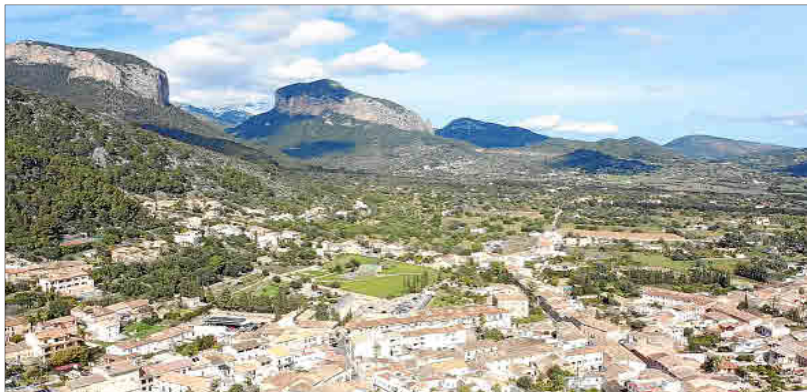
La iniciativa supondrá también la realización de mejoras en las redes hidráulicas de Alaró.
