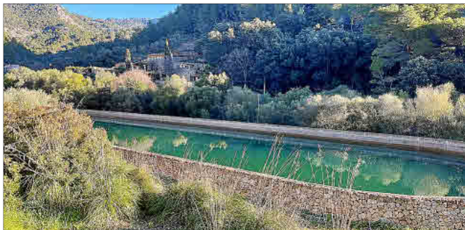
Las nuevas canalizaciones aportarán unas 70.000 toneladas anuales de agua.
