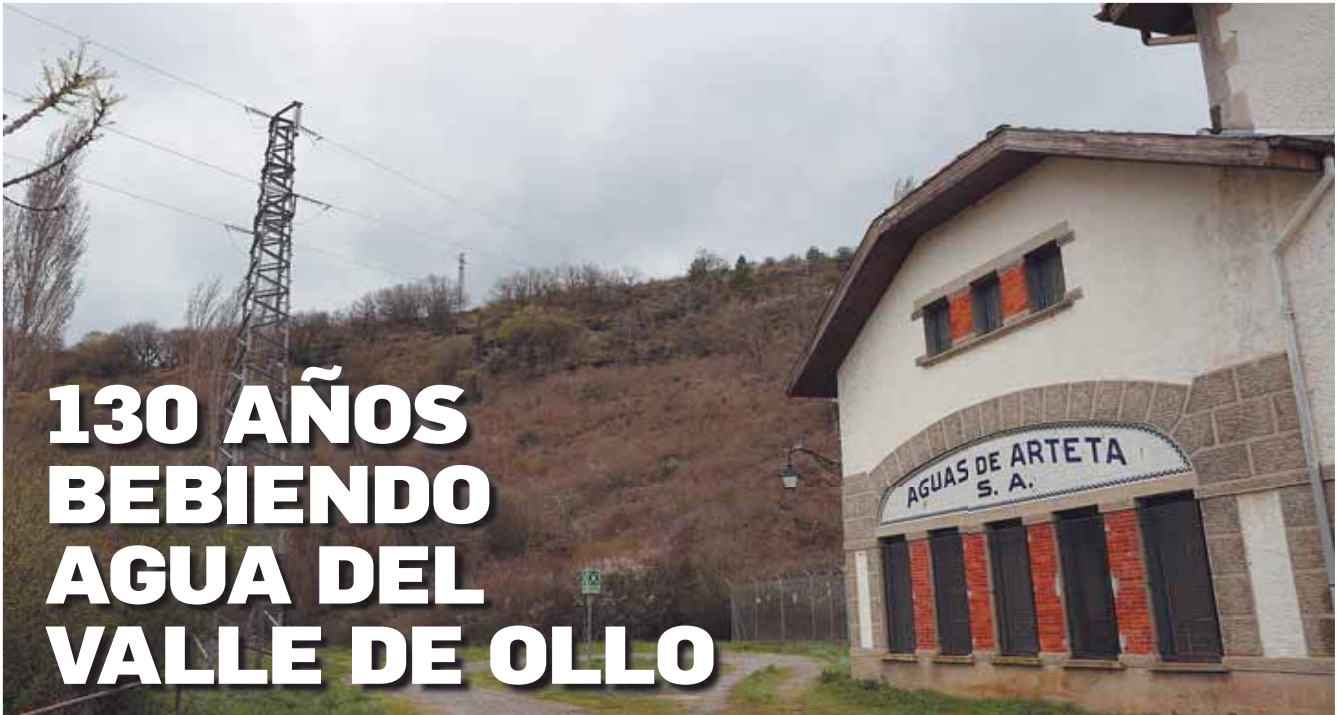
La central hidroeléctrica, situada en término del concejo de Beasoain-Egillor, en el valle de Ollo.
