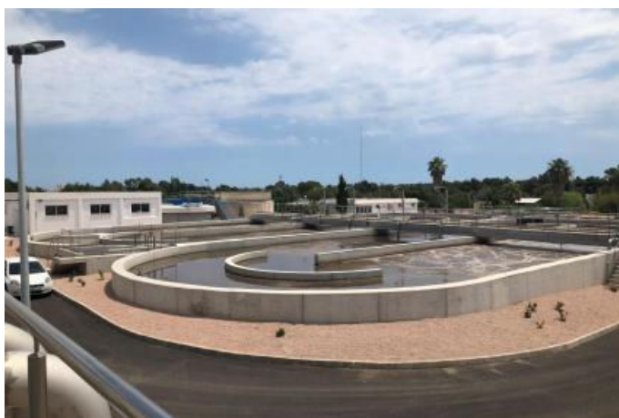
Una imagen de archivo de la depuradora
