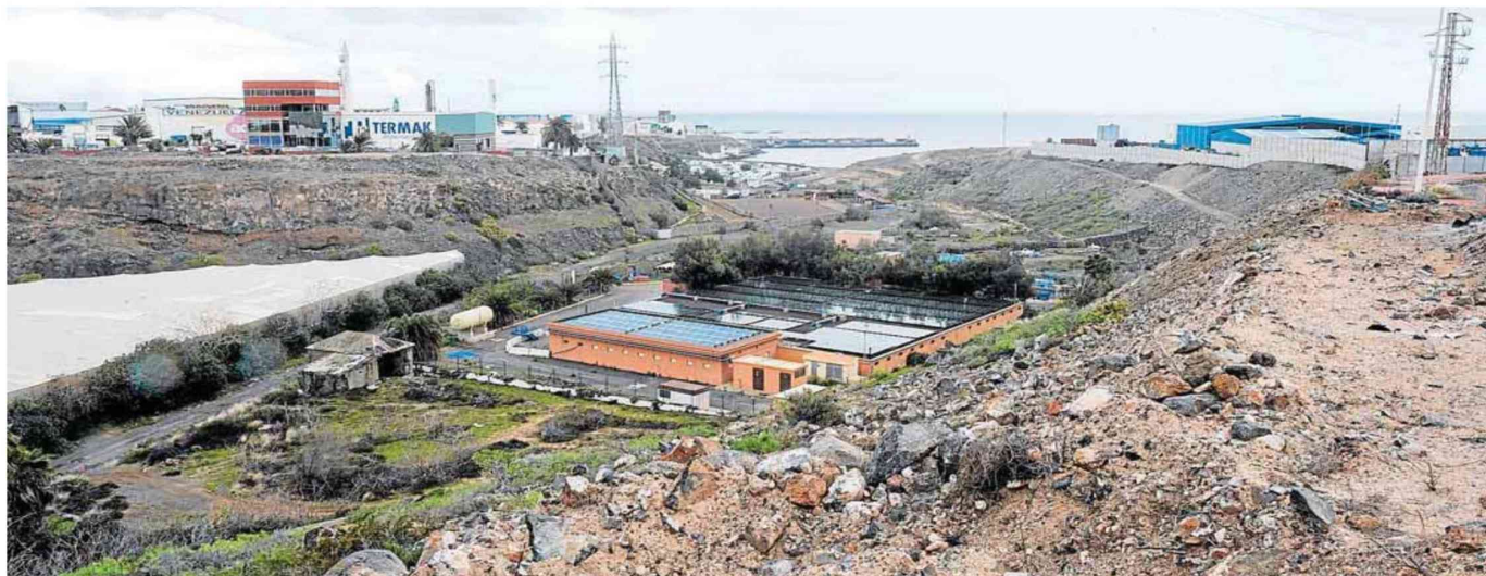
Vista de la depuradora de aguas residuales de Silva, con el puerto de Salinetas al fondo y más allá, en el mar, jaulas marinas de cría de lubinas. JUAN CARLOS ALONSO
